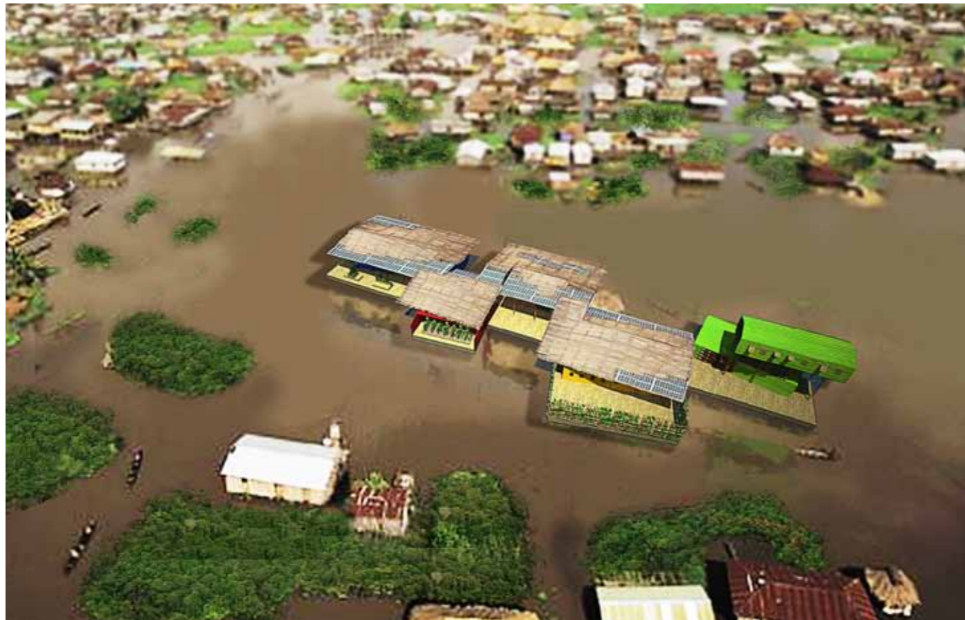
Le bâtiment flottant vient s'ancrer sur le lac, au bout du village afin que celui-ci soit accessible par le maximum de communautés du lac Tonle Sap. L'équipement est une succession de petites structures indépendantes qui reprennent la morphologie des maisons du village.
