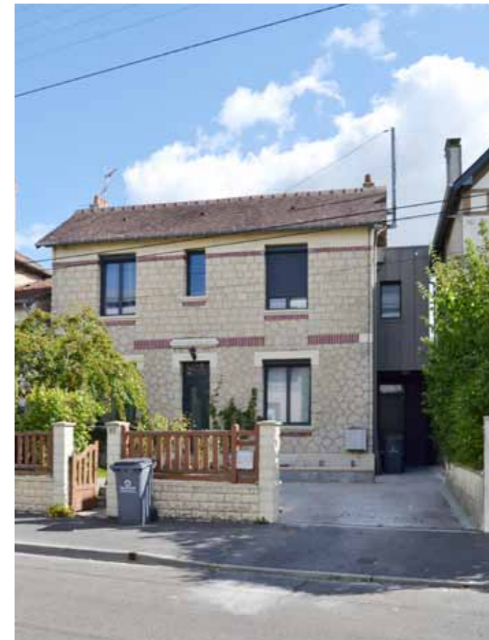
Depuis la rue l'intervention architecturale est très peu visible. Seul le mince volume habillé de zinc signale le renouveau de la maison.
