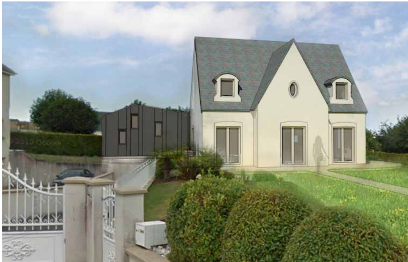
La nouvelle extension se positionne en recul par rapport à la maison existante, le long du mur de soutènement du jardin. Cette localisation face à la descente du garage lui attribue une position privilégiée. Elle donne le sentiment d'un observatoire assis sur un socle minéral.
