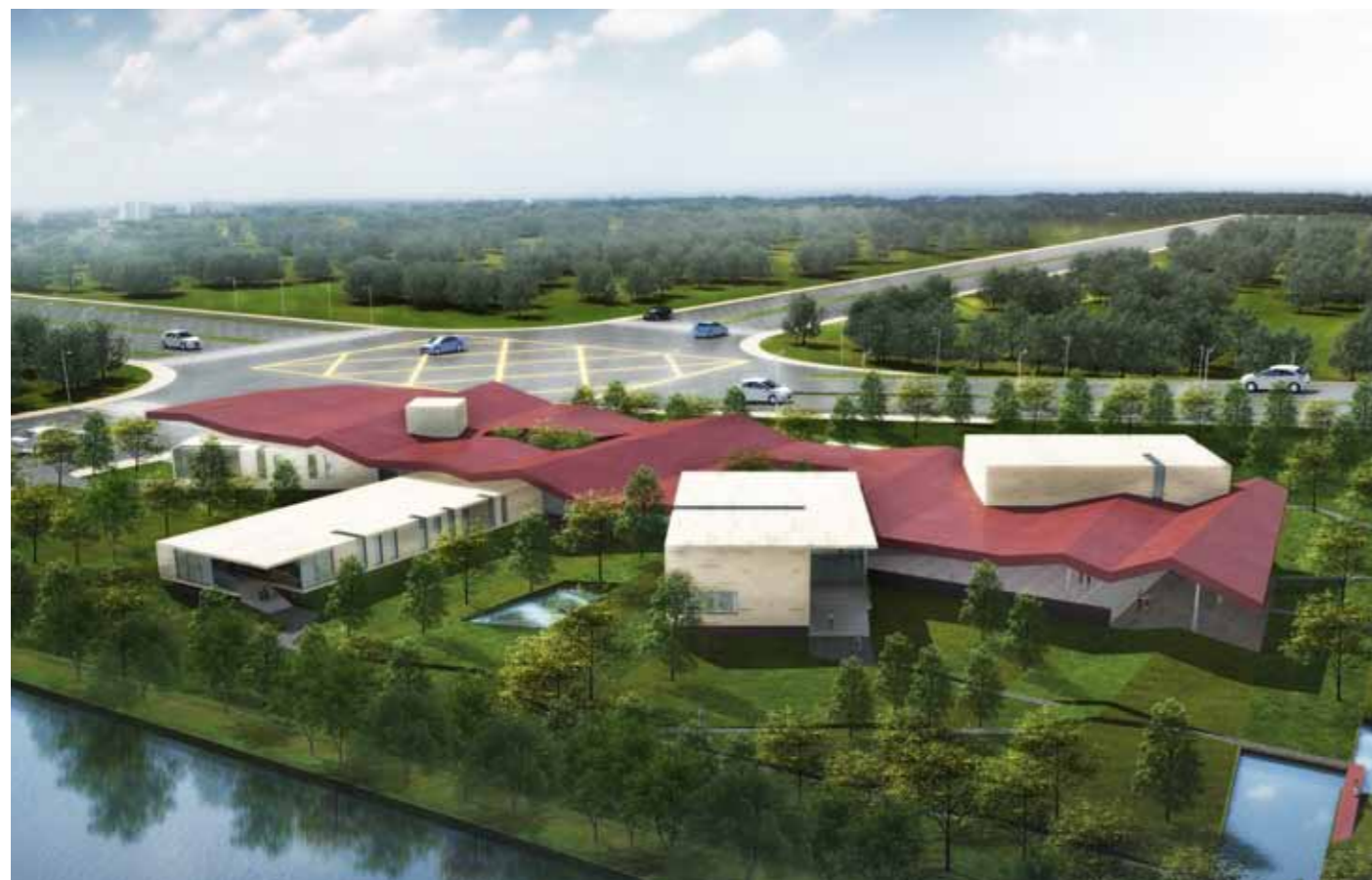
La partie arrière du projet a été traitée comme celle donnant sur la rue principale excepté que certains des volumes ont des accès directs vers le jardin.
