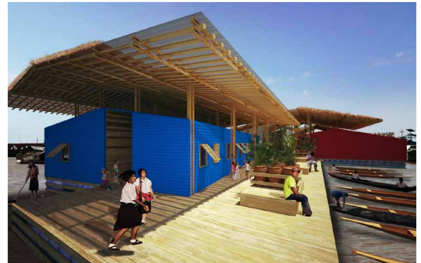
L'accès au volume bleu du pôle médical se fait par un petit passage traversant. Les fenêtres revêtues de bois naturel permettent d'occulter la vue sur l'intérieur. Elles contrastent avec le bardage bleu et donnent un rythme à la façade.
