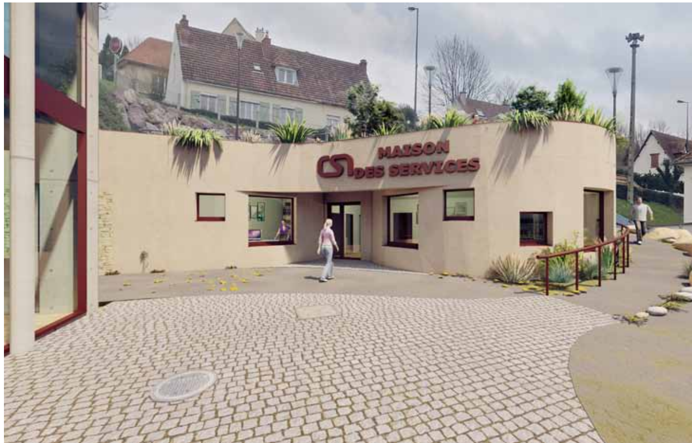
L'enveloppe de l'équipement est en béton brut teinté dans une couleur qui se rapproche de la pierre de Caen.
