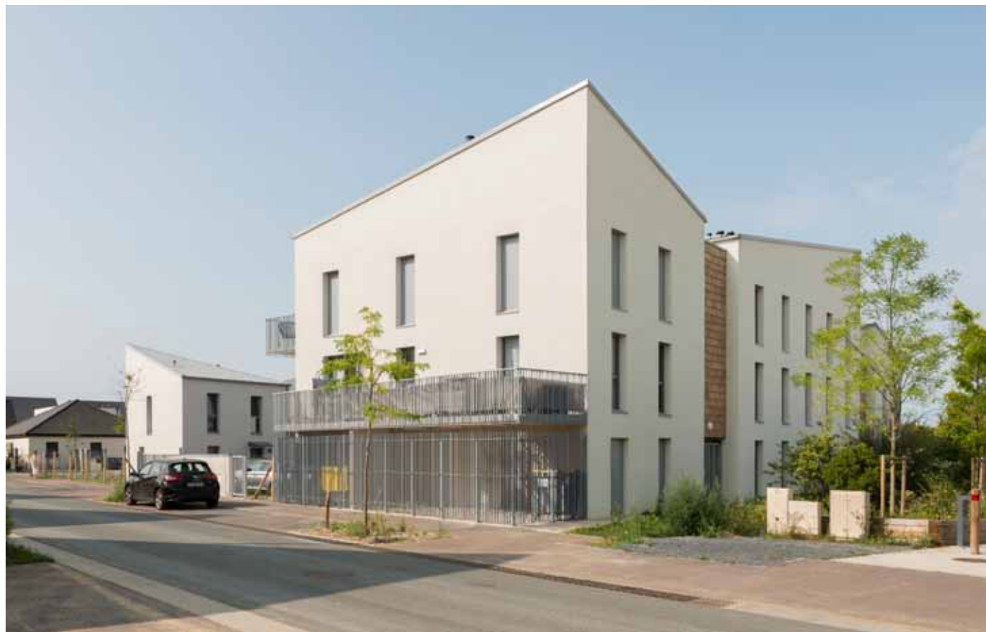
Le bâtiment de logements intermédiaires dessine un volume segmenté dont les renforcements sont habillés de tuiles de bois.
